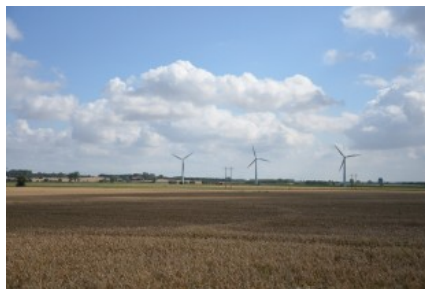
Vindmøller og højspændingsledninger i Svinninge Vejle.
